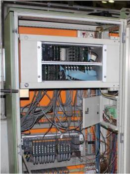
Рис. 36. Шкаф управления станом
