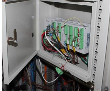
Рис. 37. Блок системы контроля режимов (СКР)
