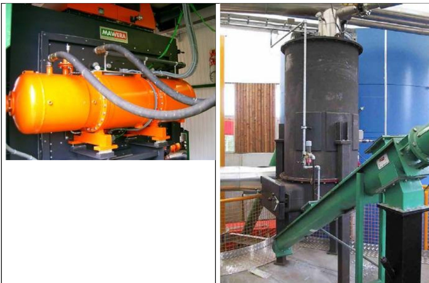
Двигатель Стирлинга на 75кВт, работающий на сжигании опилок в Австрии
