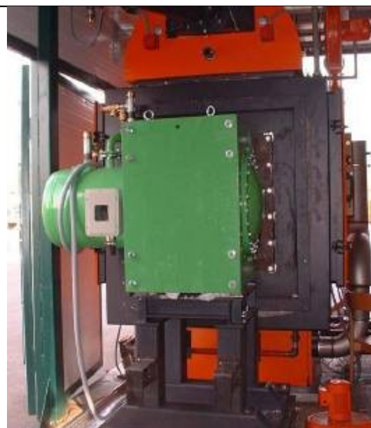
Двигатель Стирлинга на 35кВт, работающий на сжигании опилок в Австрии
